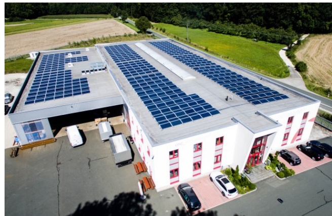
187 kWp Hofmann CNC, Gräfenberg
