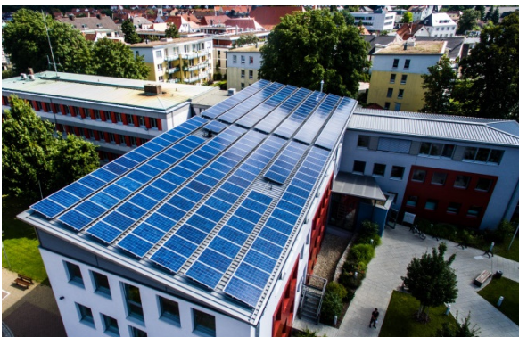
50 kWp Landratsamt, Forchheim
