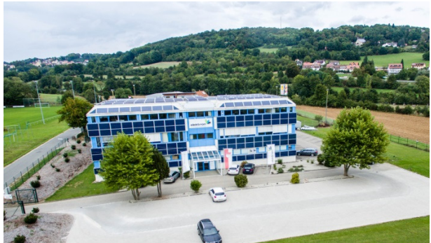
92 kWp Fassadenanlage Elektron, Weißenhohe
